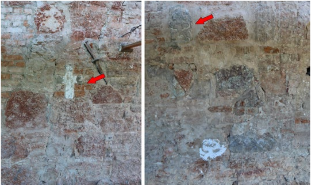
Рис. 4. Церковь Николая на Липне. 1292 г. Западная стена. Крест из плиток и каменный крест. Вид с запада. Фото: А. В. Трушникова, 2018
