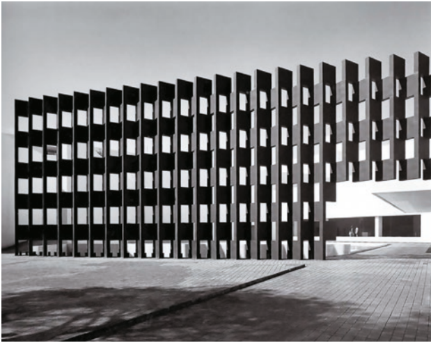
Рис. 1. Скульптурная стена на территории отеля «Камино Реал Поланко» (Camino Real Polanco). Мексика. 1968 (первоначальный вид, стена выкрашена чёрным), арх. Рикардо Легоррета, ск. Матиас Гориц
