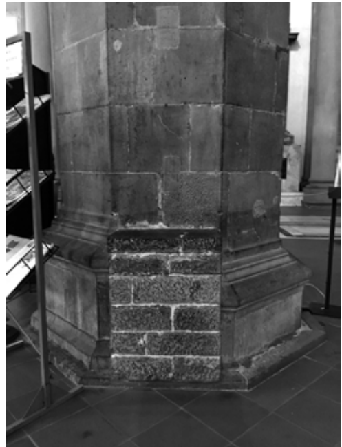
Рис. 4. Церковь Санта-Кроче. Флоренция. Опорная колонна центрального нефа. Фото Л. И. Ковальчук
