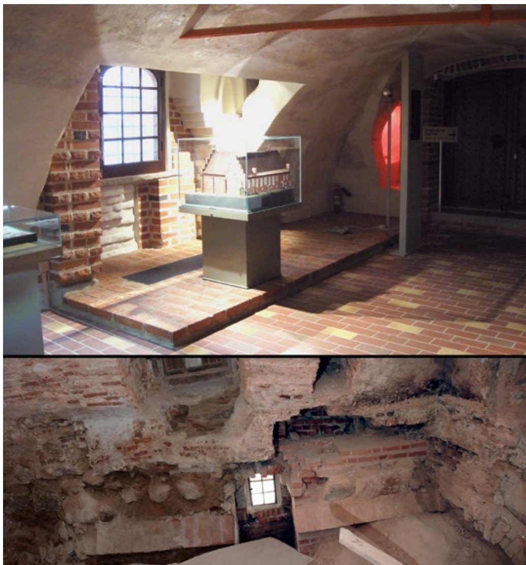
Илл. 70. Владычная палата в Великом Новгороде. Сохранившиеся фрагменты отопительной камеры в восточной части палаты: современное состояние после реставрации (вверху); в процессе исследований (внизу). Фотографии Д. Е. Яковлева
